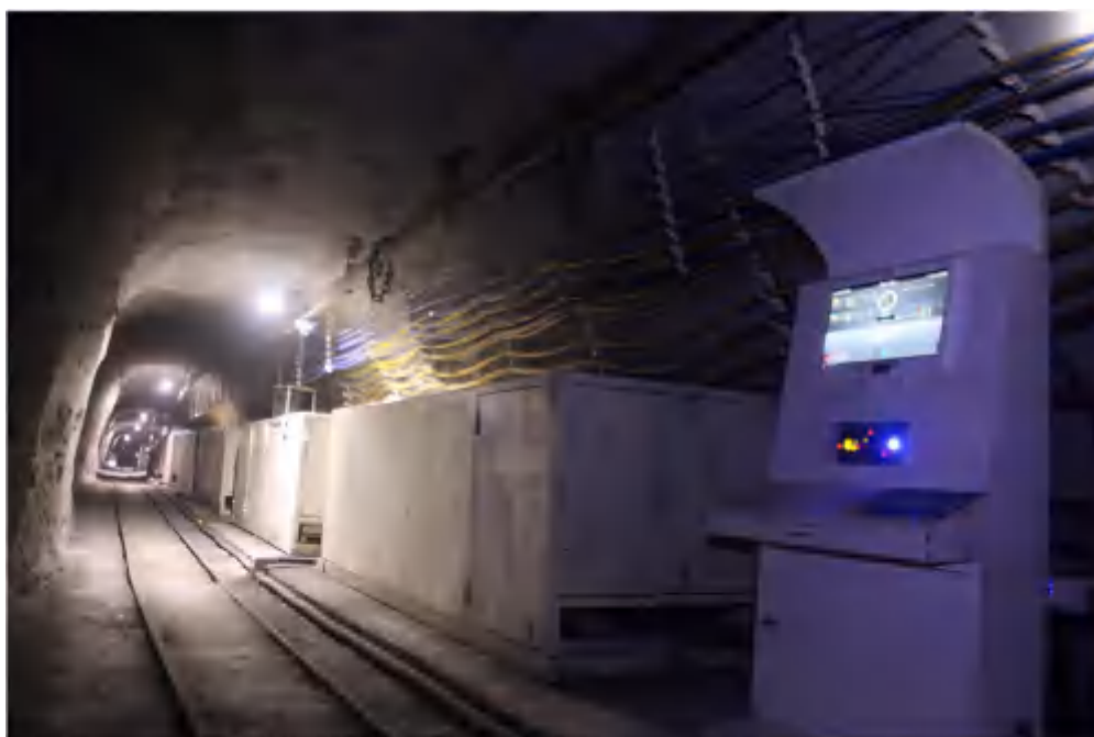
图 2 集成供液系统安装硐室
